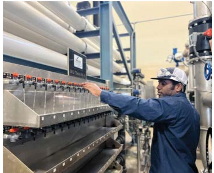
**Personal de operaciones probando las membranas de la Planta Desaladora**
